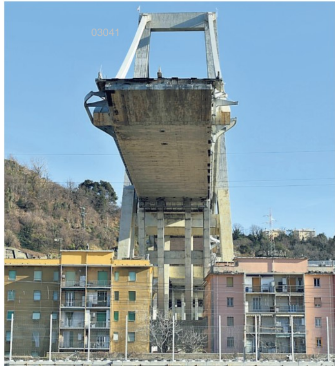
I resti del Morandi, e i palazzi sotto, prima delle demolizioni
